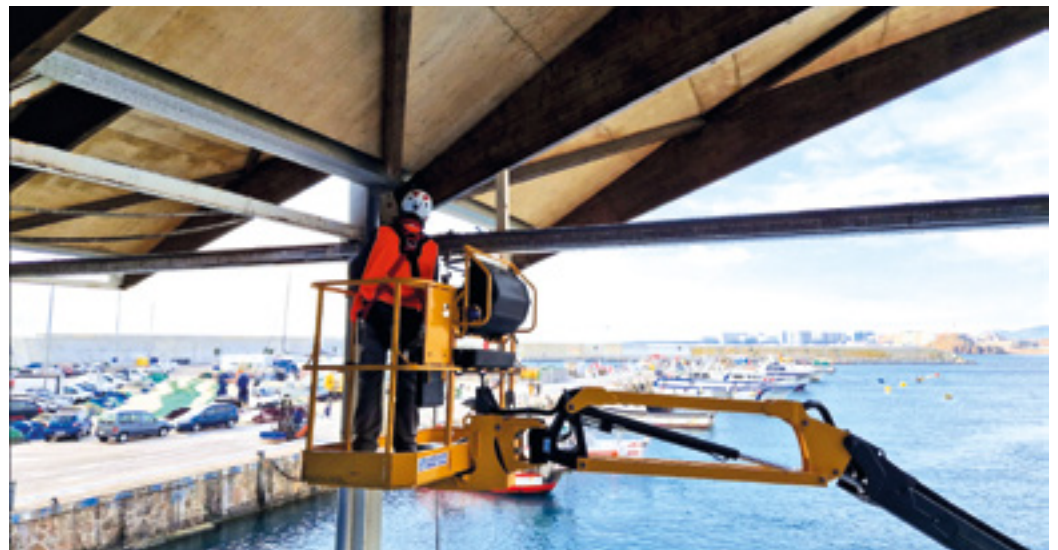
Obres a la coberta de la llotja del port de Blanes
